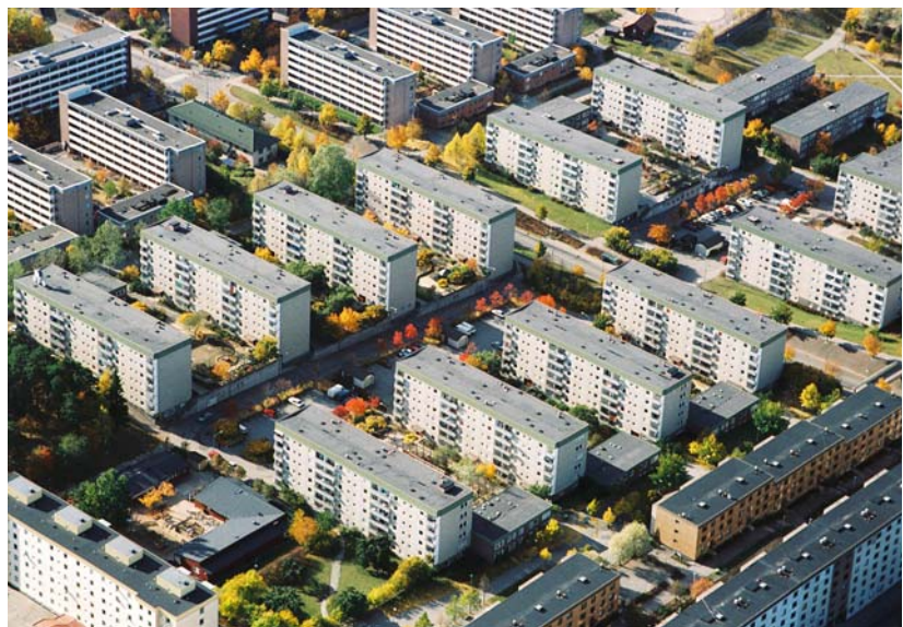
Lamellhus med platta tak. Tensta 1960-talet. Foto Ingrid Johansson.
