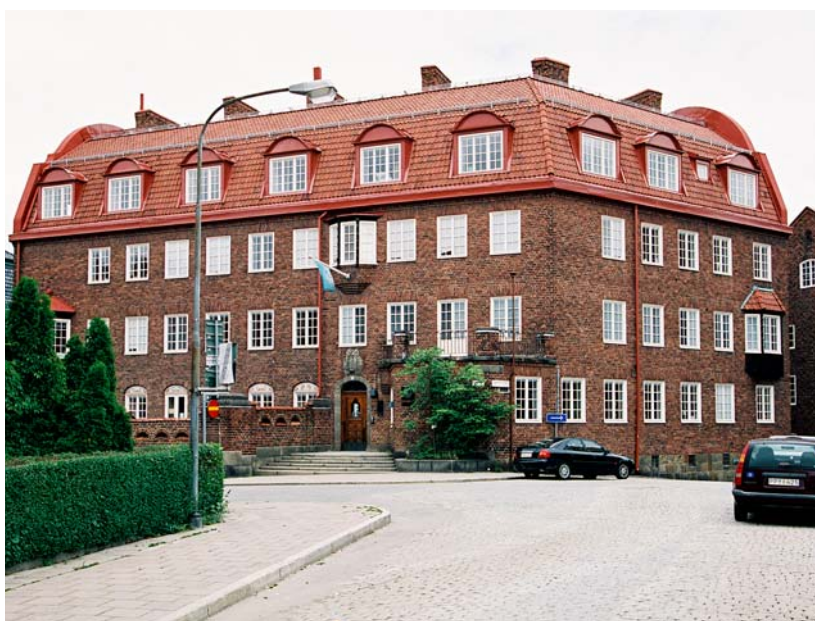
Karakteristiskt för 1910-talet är ett brutet tegelklätt tak med takkupor på det nedre branta takfallet. Huset ligger i Lärkstaden. Foto Ingrid Johansson.
