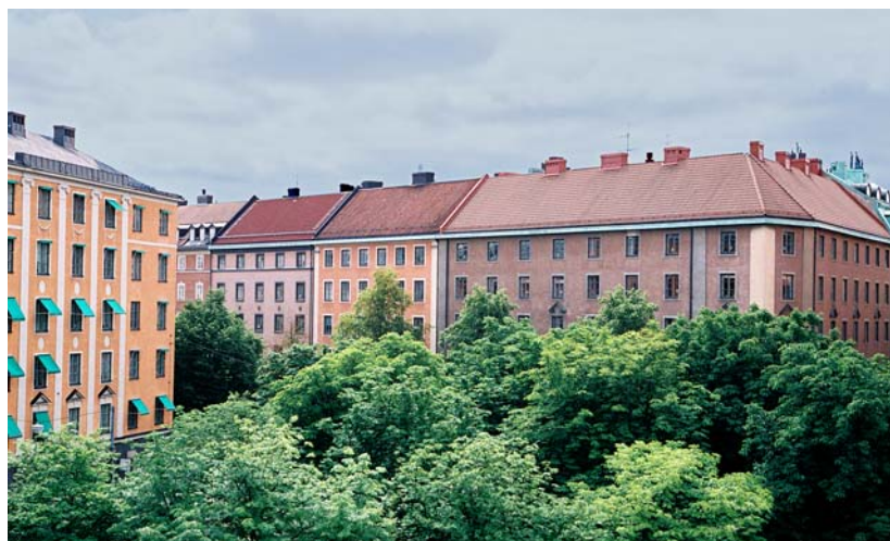
Enhetliga tegelklädda tak från 1920-talet i Eriksbergsområdet utgör ett positivt inslag i stadsmiljön. Foto Ingrid Johansson.
