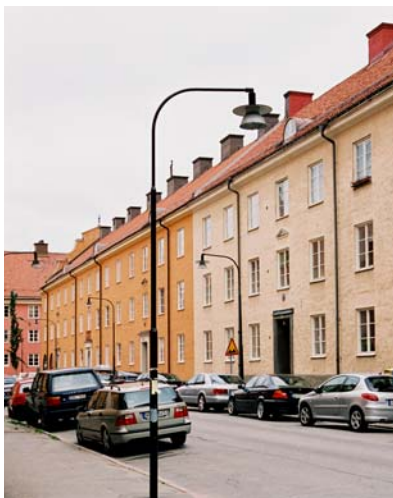
1920-tals husen utmed Falugatan i Röda Bergsområdet är välbevarade med tegelklädda flacka tak med enkasta dekorativa lunettfönster som ger ljus till vinden. Foto Ingrid Johansson.
