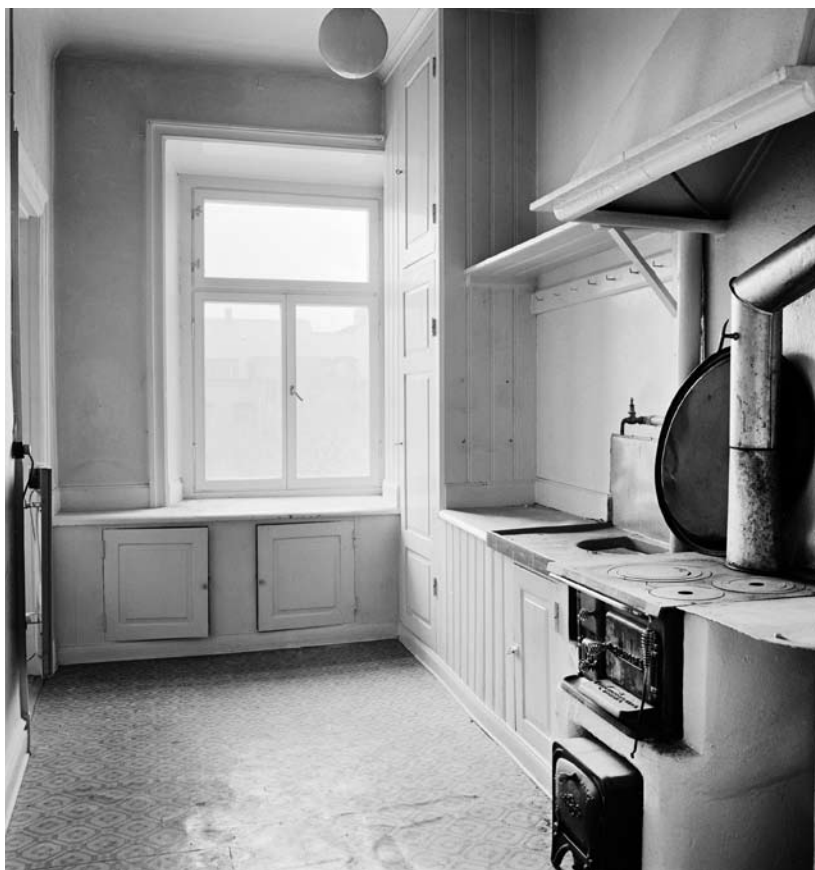
Kök från 1880-talet med väggfast bänk och friskluftsventilerat skafferi mot ytterväggen. Den enda utrustningen består av vedspisen under plåtkupan och kallvattenkranen över en enkel ho klädd i zinkplåt. Fleminggatan, Kungsholmen. Huset är byggt 1885-86. Foto: Stina Brockman.
