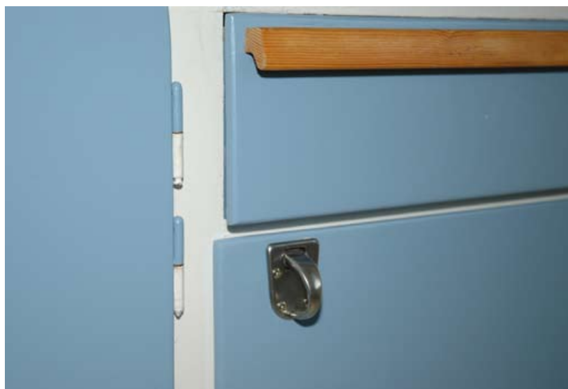
Pinngångjärn och det klassiska griphandtaget på luckor i 1950-talskök, Blackeberg. Intill syns även den trärena list som ofta användes som handtag på lådor under 1940- och 1950-tal. Foto: Göran Fredriksson.
