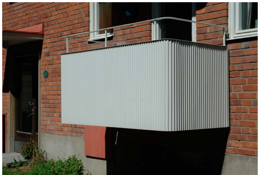
Här har ny småsinusplåt med slät yta monterats på ett renoverat smidesräcke. Resultatet är mycket bra. 1940-talshus. Åkeslund. Foto Göran Fredriksson.
