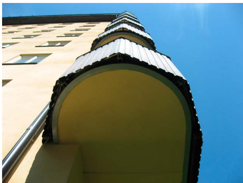
Funkishusets rundade plattor är ursprungliga. Vid bytet av räckan till trp-aluminium gick den rundade, svepande formen om intet. Gärdet. Foto Martin Lagergren.
