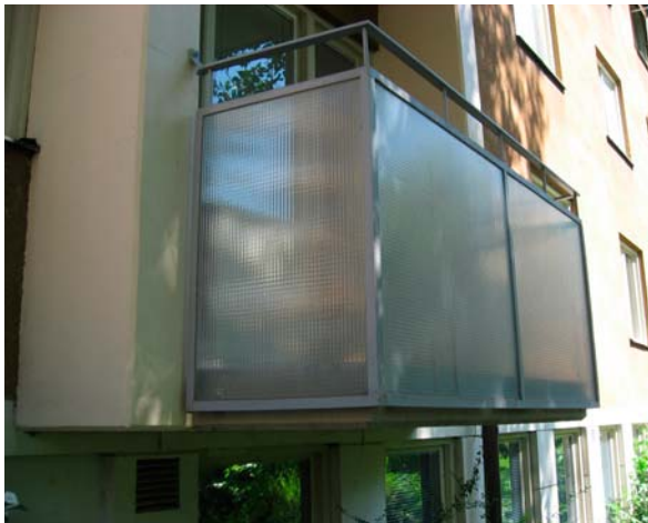
Glasfronter i smäckra smidesramar förekommer på 1940- och 50-talen. Många räcken av den här typen har bytts ut och ersatts av aluminium. Gärdet. Foto Martin Lagergren.
