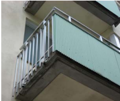
Olackerat, ej gerat aluminiumräcke. Tätt placerade blanka nitar och skarvat, knottigt aluminiumräcke. Ställ högre krav än så! Gärdet. Foto Martin Lagergren.
