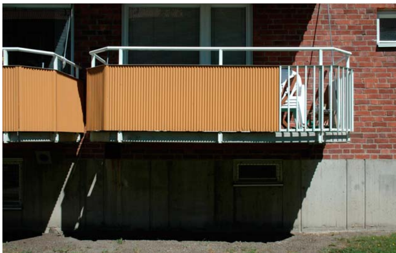
I stället för att gjuta en ny platta kring armeringen lät man här hänga nya mycket stora prefab-plattor i dragstag i väggen. Byggnaden från 1950-talet förvanskades. Högdalen. Foto Göran Fredriksson.
