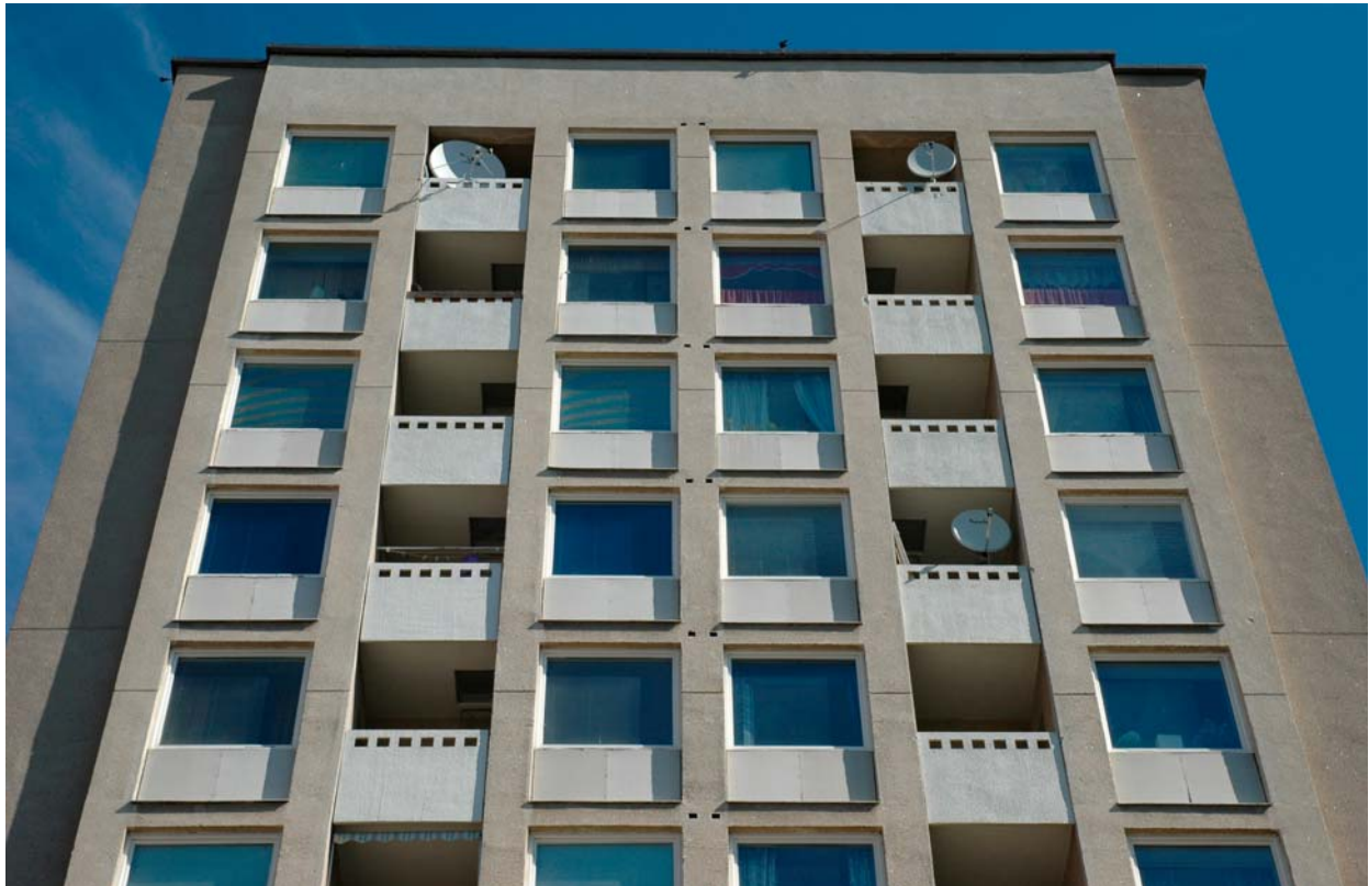
Betongräcken med stor betydelse för byggnadens helhetsuttryck. Vällingby. Foto Göran Fredriksson.
