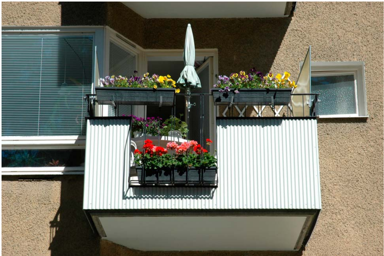
1950-talsbalkong med plats för blomlådor i smidesracket. Smidesstommen har kompletterats med en ny småsinuskorrugerad front i aluminium. En varsam lösning som bevarar husets karaktär och särart. Blackeberg. Foto Göran Fredriksson.
