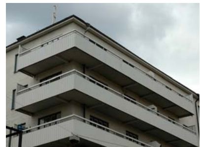
HSB:s bostadskvarter Färjan på Kungsholmen från sent 1920-tal. De stora hörnbalkongerna som ursprungligen hade helt släta räcken med synlig plattkant har fått nya räcken med mycket grova överliggare av olackerad aluminium och för långt neddragna fronter i vitt standardutförande. Foto Göran Fredriksson.
