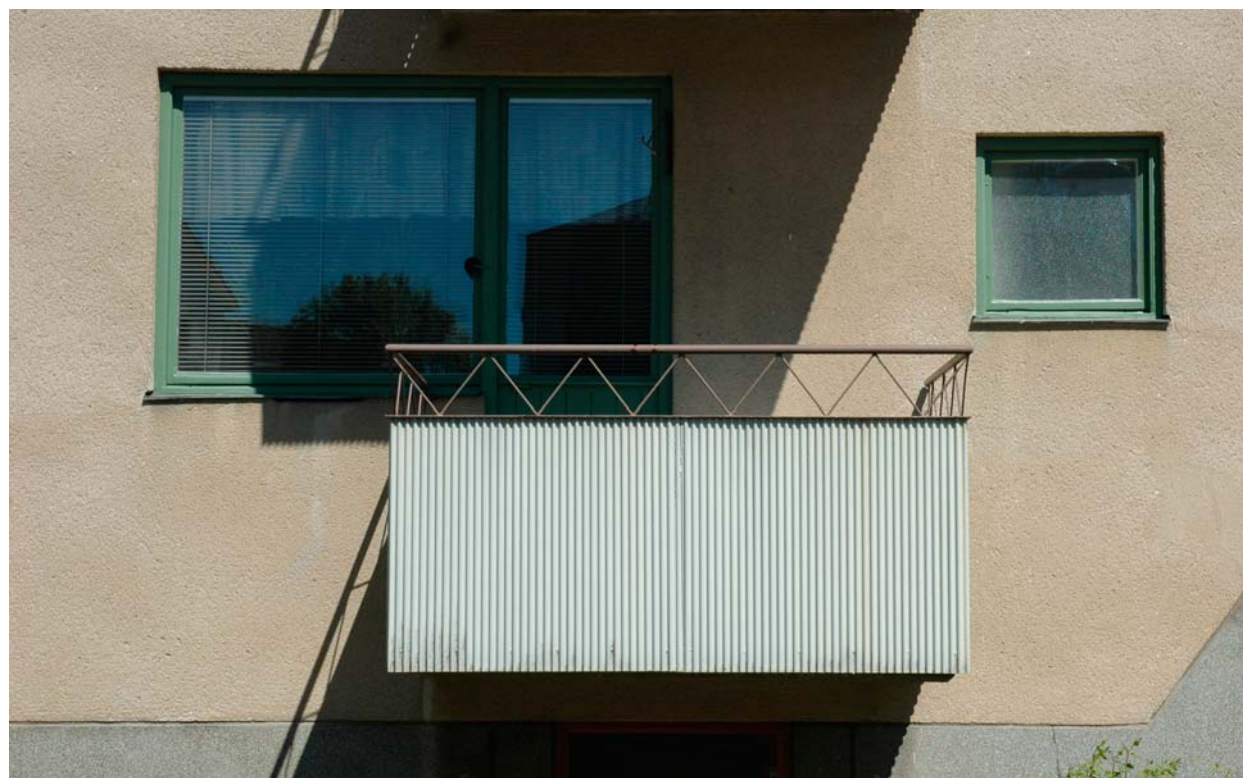
Ursprungligt smidesräcke från 1950-talet väl värt att underhålla. Zig-zagmönstret kan inte kopieras i aluminium! Bandhagen. Foto Göran Fredriksson.
