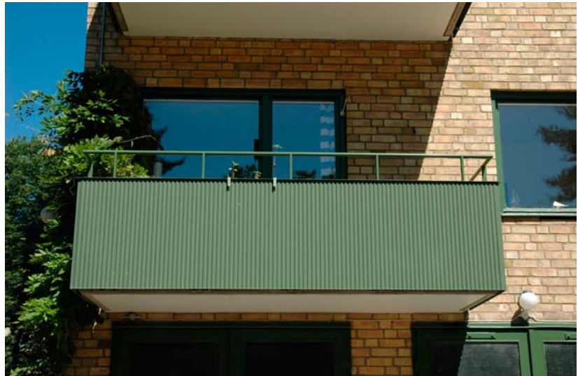
Väl utförd aluminiumbalkong. Smäcker, lackerad överliggare, sinusplåt med slät yta och lackerade nitar. Observera hur fronten slutar i höjd med plattan. Alvik. Foto Göran Fredriksson.
