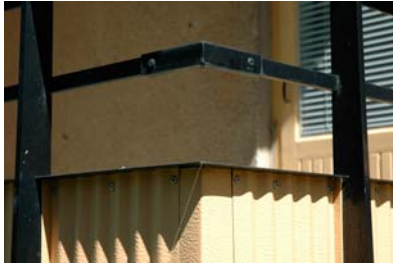
Aluminiumräcket är smäckert och lackerat men plåten är knottig, skarvad och nitad med blanka nitar. Högdalen. Fotograf Göran Fredriksson.
