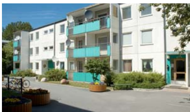
Elementbyggt trevåningshus med utvändiga balkongkonstruktioner. Tensta. Foto Göran Fredriksson.
