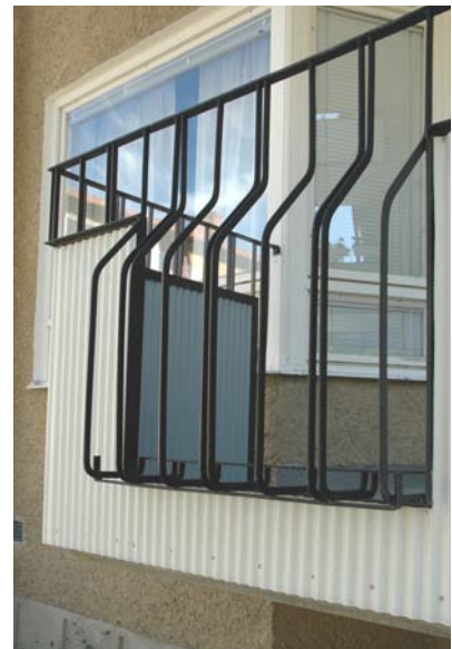
Balkongräcken med plats för blomlådor var vanliga under åren kring 1950. Blackeberg. Foto Göran Fredriksson.
