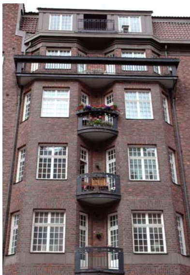
Exempel på 1910-talets kraftfulla tegelarkitektur med specialformgivna balkongräckan i anslutning till burspråken. Vasastaden. Foto Göran Fredriksson.
