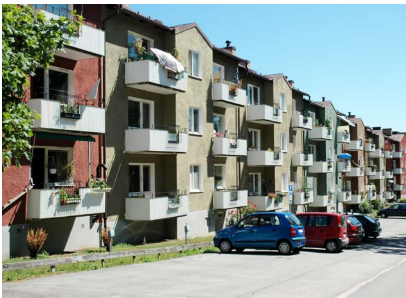
De allra flesta 1950-talslägenheter har balkong. Vanligtvis är de placerade mot söder eller väster för soljuset. Västertorp. Foto Göran Fredriksson.
