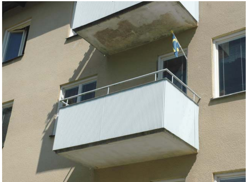
Karaktäristisk 1940-talsbalkong med småsinusplåt som lämnar bottenplattans kant synlig. Räcket med rund överligger och fronten är färgsatt i samma kulör. Balkongen ger ett lätt och distinkt intryck. Gubbängen. Foto Göran Fredriksson.
