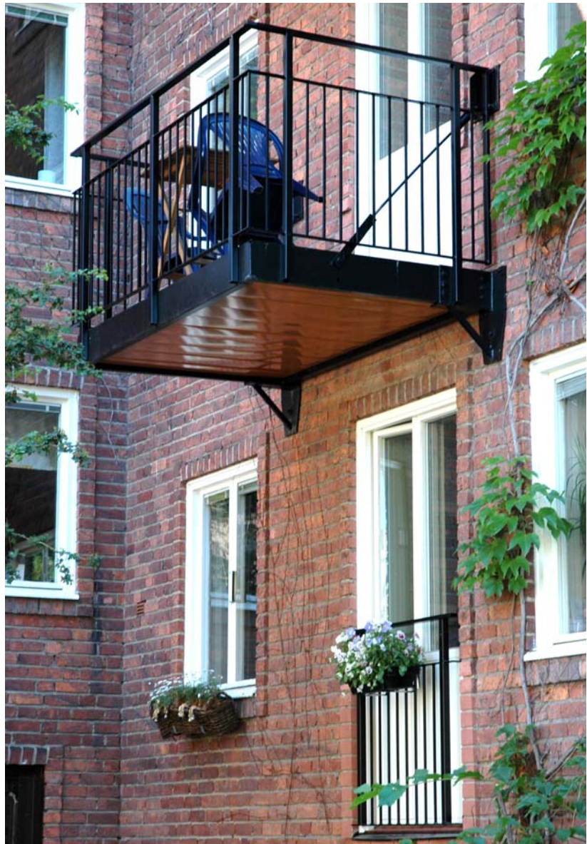
Den nya balkongen är placerad rakt ovanför vardagsrummet i lägenheten under. Södermalm. Foto Göran Fredriksson.
