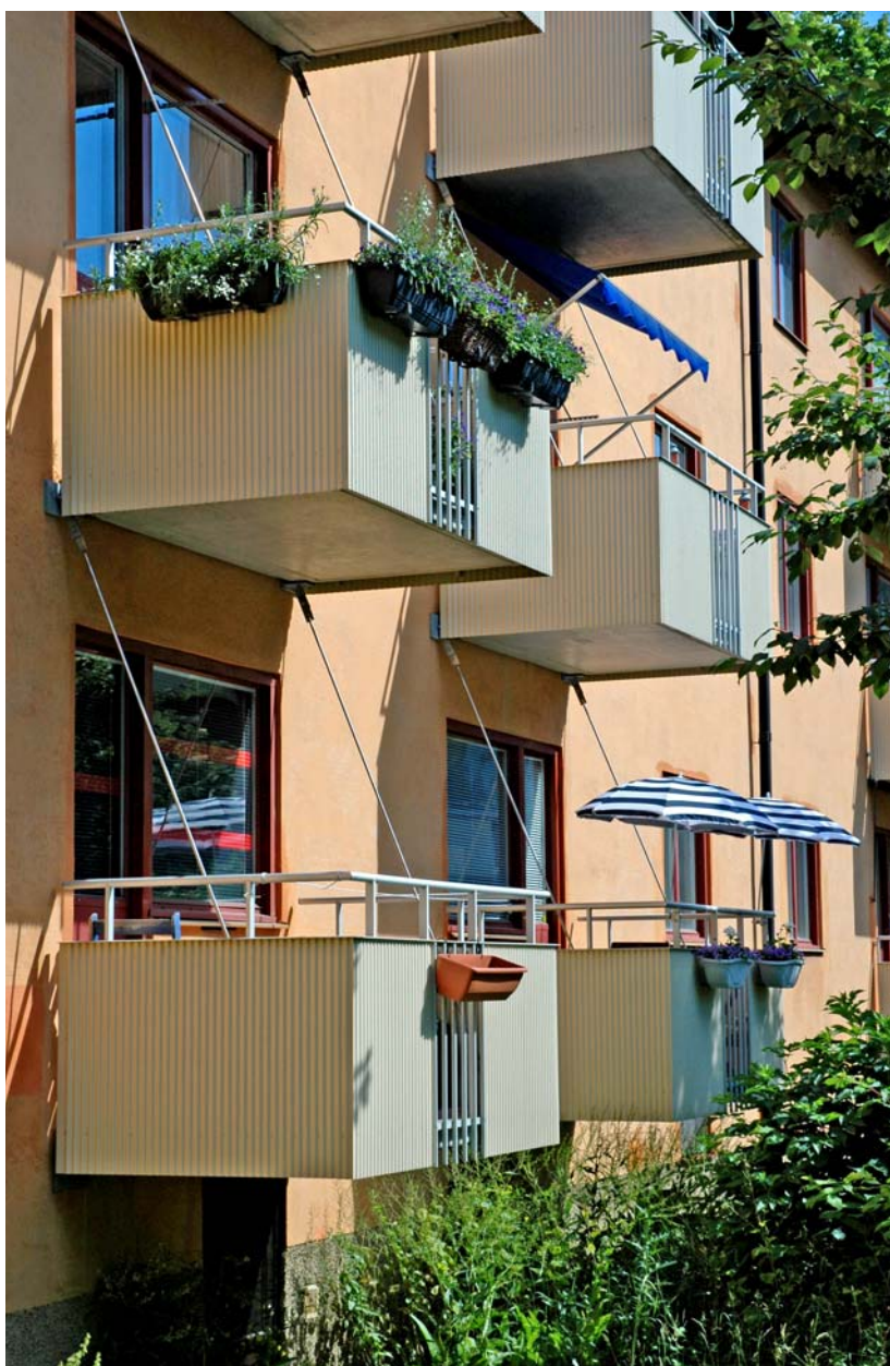
Nybyggda balkonger har ersatt franska balkonger på ett smalhus i Riksby. Väningshöga dragstag av stål bär plattorna. Förändringen av husets arkitektur är påtaglig. Foto Göran Fredriksson.
