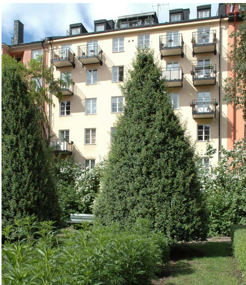
I Vasastaden har detta hus med fasad mot en parkmiljö försetts med balkonger. Alla lägenhetsinnehavare har inte valt att bygga balkong. Resultatet blir en spolerad fasadutformning och en orolig helhetsverkan. Vid vindsinredningen har en takaltan byggts i takfallet. Foto Göran Fredriksson.
