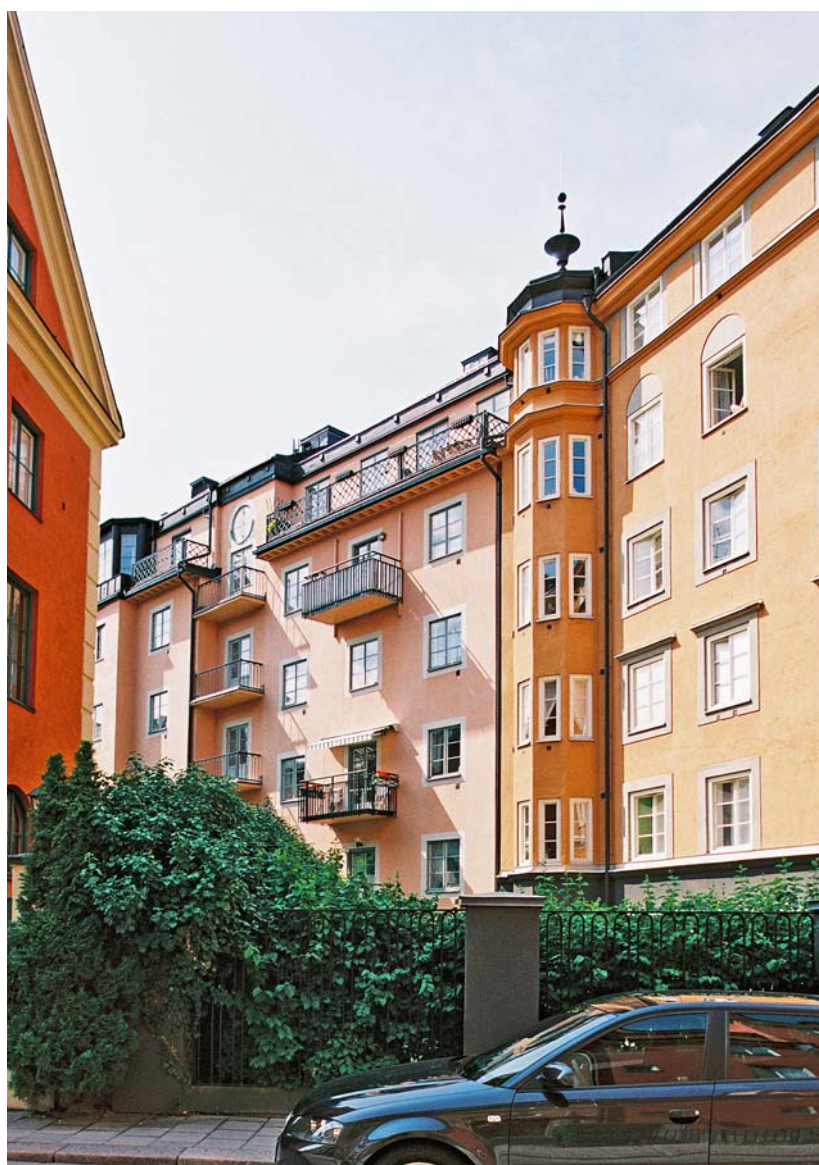
Danderydsgatan på Östermalm är en unik gatumiljö med påkostad 1920-talsbebyggelse i den mindre skalan. Här har nya balkonger byggts i den halvöppna gårdsmiljön som är synlig från gatan. Foto Ingrid Johansson.
