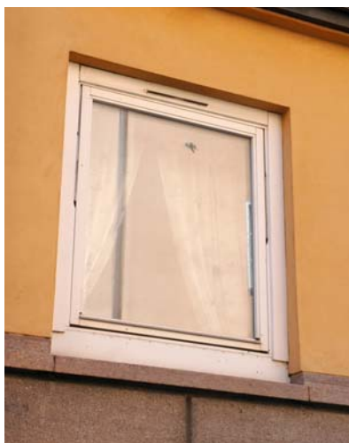
Pivohängda fönster utan spröjsar har ersatt sexdelade fönster från 1920-talet. Foto Göran Fredriksson.
