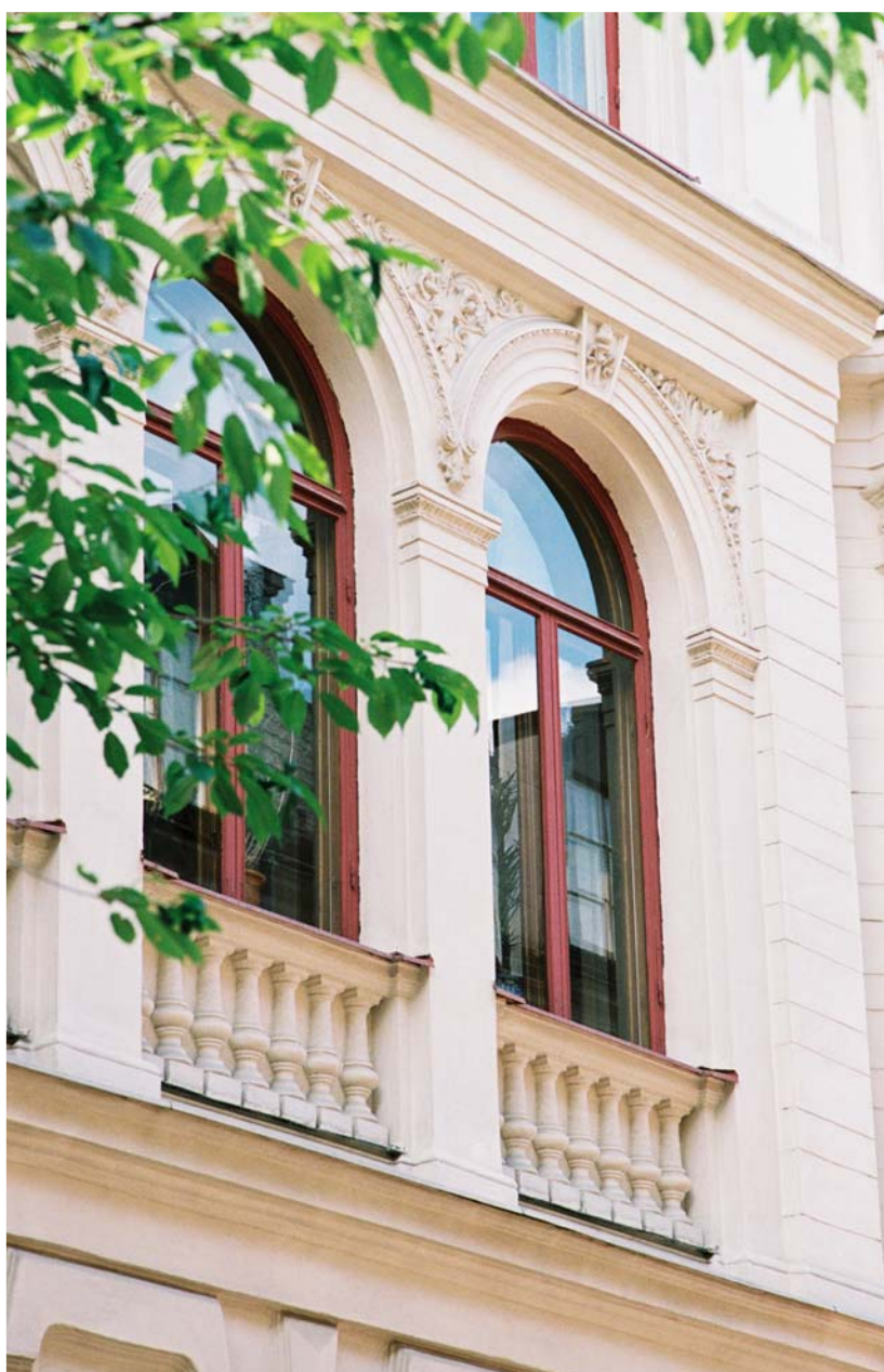
Okopplat fönster med rikt profilerad omfattning. 1880-tal. Södermalm. Foto Ingrid Johansson.
