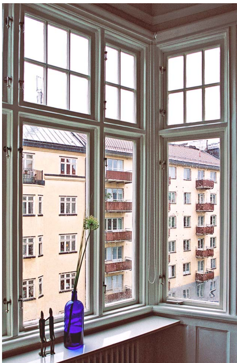
Ett hundra år gammalt jugendfönster mot Hornsgatan har renoverats och bullerisolerats genom att det inre glaset bytts mot en tjockare ruta. Förändringen är knappt synbar. Foto Ingrid Johansson.
