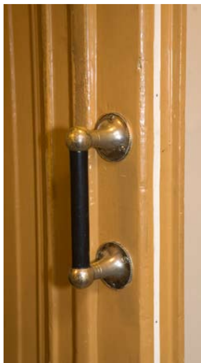
Infräst svällist i en dörr från sent 1800-tal, Södermalm. Listen sväller vid upphettning och för att fungera är det viktigt att den inte är övermålad. Foto: Göran Fredriksson.
