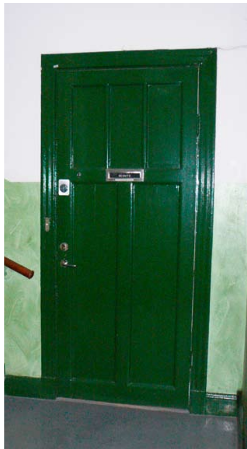
En enkel fyllningsdörr utan glas i ett mindre påkostat hus från tidigt 1900-tal, Södermalm. Foto: Hanna Gärdstedt.
