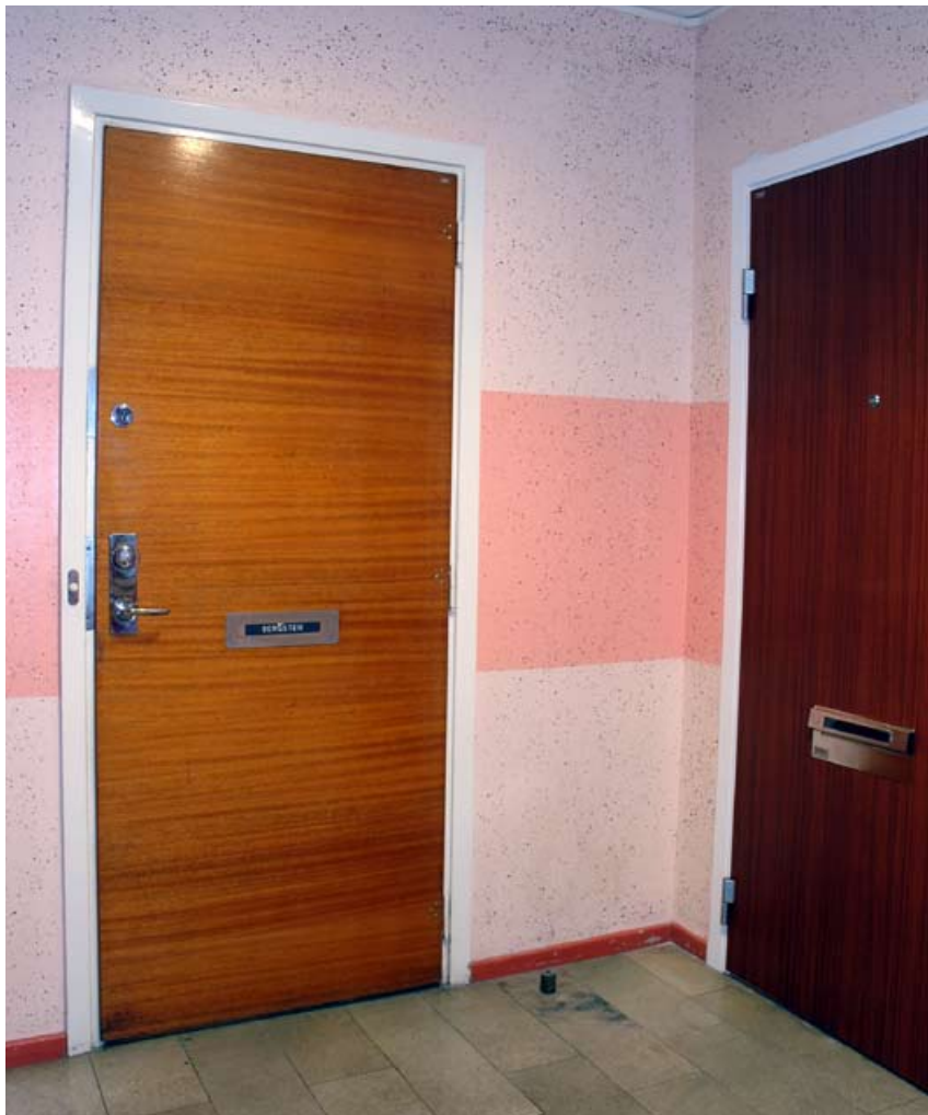
Vänster: En slät dörr från 1950-talet, Blackeberg. Intill skymtar en ny säkerhetsdörr i stål med en yta av träimiterande plastfilm. Foto: Göran Fredriksson.
