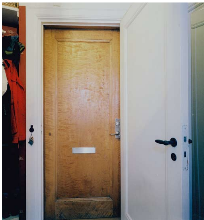
En fyllningsdörr i björkfaner från 1930-talet med en enda stor fyllning. Innanför dörren sitter en innerdörr som dämpar ljudet från trapphuset, Kungsholmen. Foto: Ingrid Johansson.
