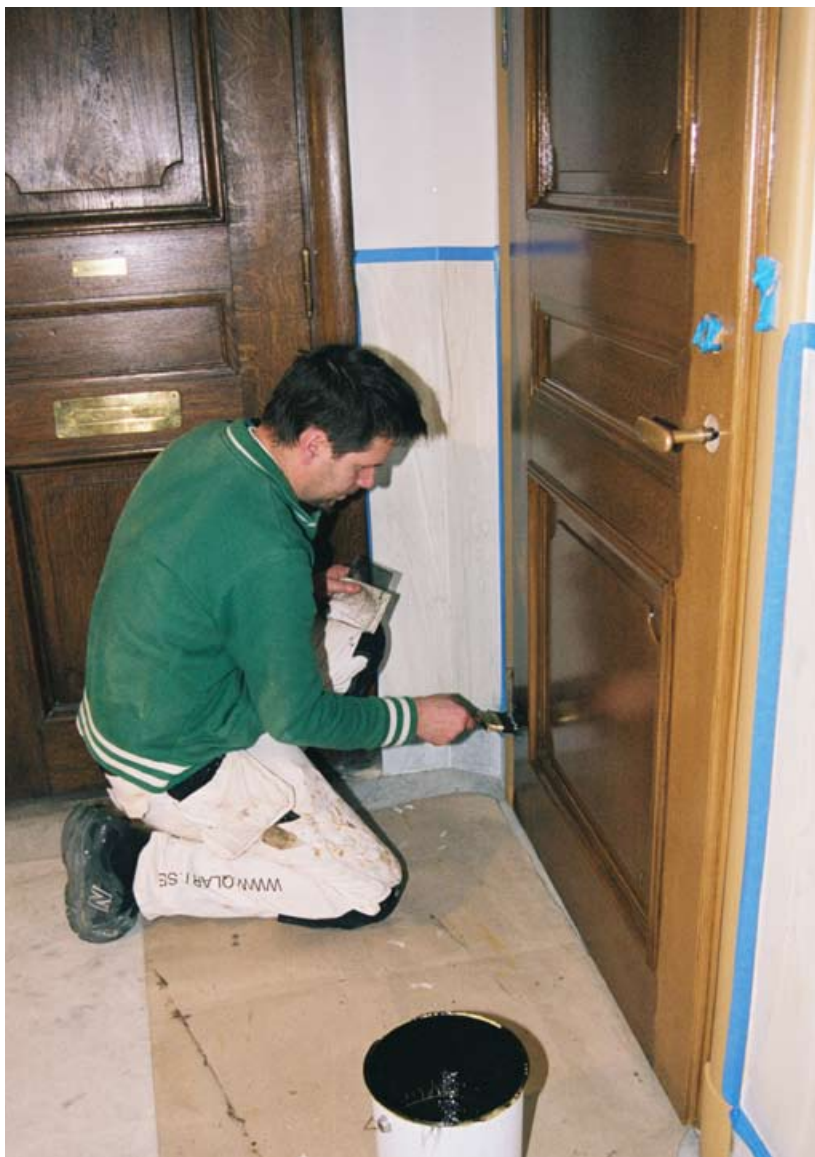
Ådringsmålning av lägenhetsdörr, Östermalm. Vid renovering av kulturhistoriskt värdefull bebyggelse är det alltid viktigt att anlita hantverkare med erfarenhet av värdefulla miljöer. Foto: Ingrid Johansson.
