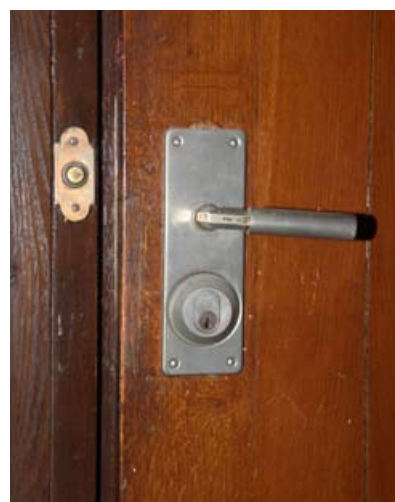
Ursprunglig ringklocka och dörrhandtag på en 1930-talsdörr, Östermalm. Detaljer som handtag och brevinkast har stor betydelse för upplevelsen av dörren och trapphuset. Foto: Ingrid Johansson.
